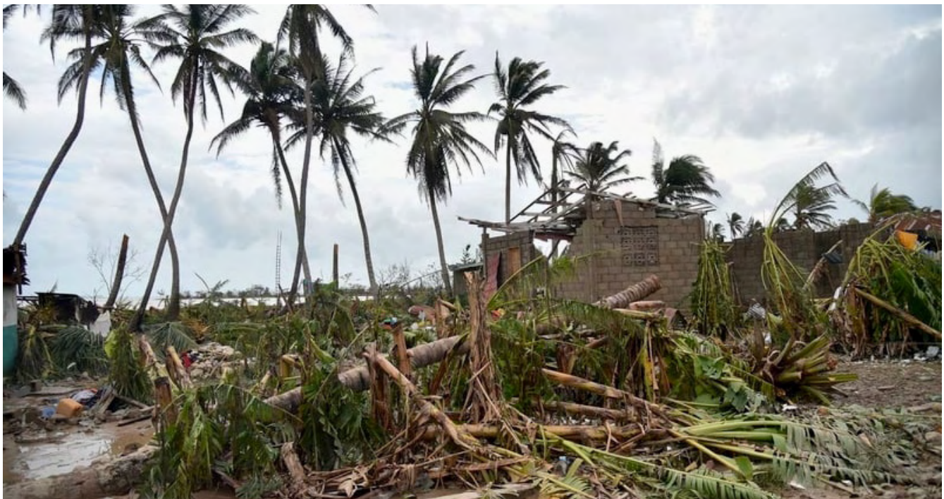
Les dégâts de l'ouragan Matthew, octobre 2016 | © rte.ie
